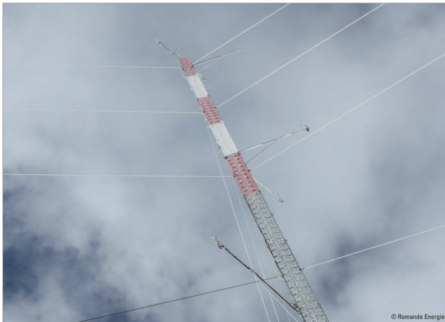
Un des trois mâts de mesure installé dans le périmètre du projet de parc éolien de Provence
