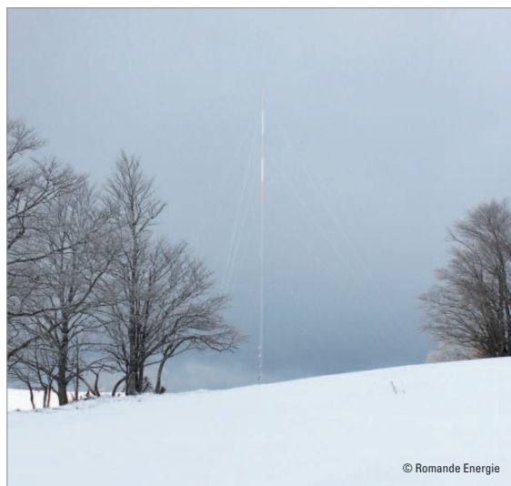
Mât de mesure d'une hauteur de 80 mètres
