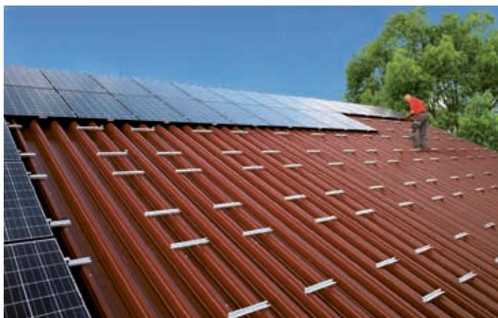
*Illustration 55: Solution typique pour systèmes intégrés à la toiture. Dans le système Solrif, les modules PV sont équipés d'un cadre spécial leur permettant de jouer le rôle des tuiles (Ernst Schweizer Metallbau).*
