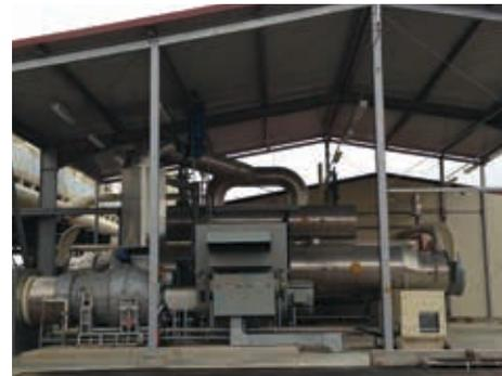
*Illustration 195. Centrale géothermique d'Insheim avec procédé ORC. Turbine et générateur, à l'arrière échangeur de chaleur à tubes et évaporateur. ORC = Organic Rankine Cycle.*
