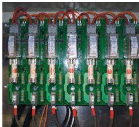
*Illustration 49: Fusibles à courant continu et indications de mesure dans un coffret de raccordement de générateur (Basler & Hofmann AG).*
